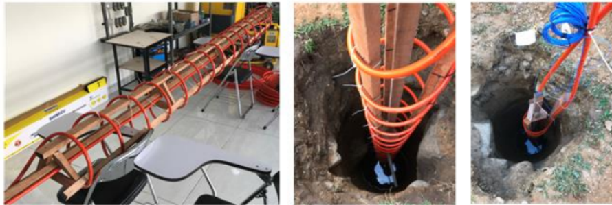
Fig. 1. Spiral-tube GHE.
